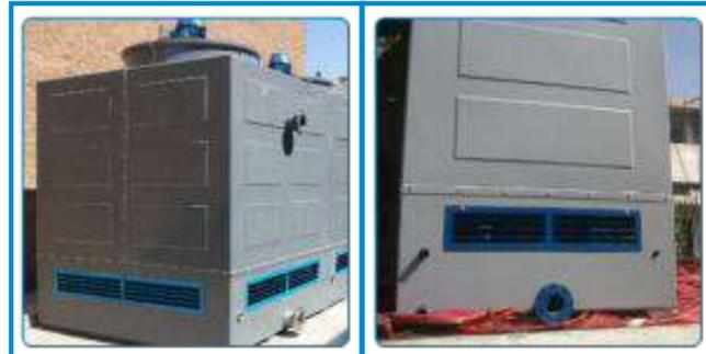
Fabricación de torres de enfriamiento de acuerdo a las necesidades de proceso, se realizan cálculos de carga calorífica y poder determinar las dimensiones de la torre de enfriamiento y los intercambiadores de calor de casco y tubos en materiales como acero al carbón o cobre estriado para optimizar la transferencia de calor y disminuir las incrustaciones.
