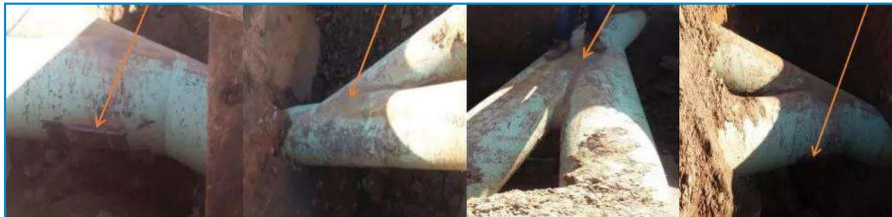
Hay una rotura en la línea principal de agua que suministra desde los pozos de extracción a la planta, la reparación se realiza mediante la pasta de reparación de curado rápido UPS125 XFP Fast Curing Metal Paste y esta reparación se refuerza con el vendaje de reparación UPS 19605 PR en el ducto de 22 pulgadas.
