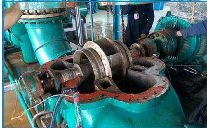
UPS Ltd. en Reino Unido, recientemente completó una aplicación de reparación y reacondicionamiento para dos ensambles completos de bombas centrífugas CCW en una estación de generación de energía.
